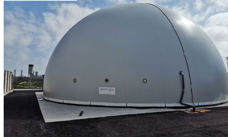
Depuratore di Brindisi
